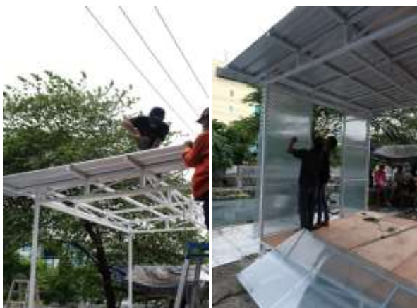
Gambar 12. Proses Pemasangan Penutup Atap dan Panel Dinding Unit Isolasi (Sumber: Dokumentasi Pribadi, 2020)
