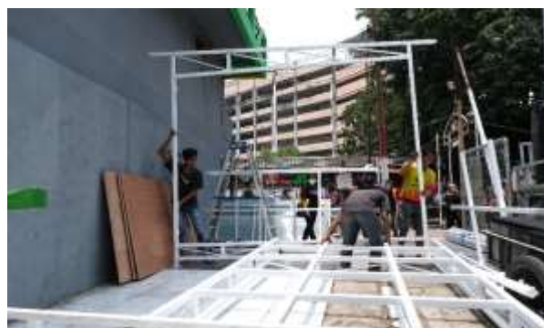
Gambar 9. Proses Pemasangan Rangka Dinding Unit Isolasi (Sumber: Dokumentasi Pribadi, 2020)
