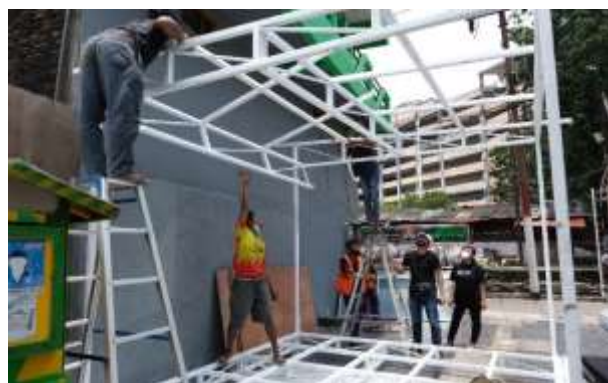
Gambar 10. Proses Pemasangan Rangka Atap Unit Isolasi (Sumber: Dokumentasi Pribadi, 2020)
