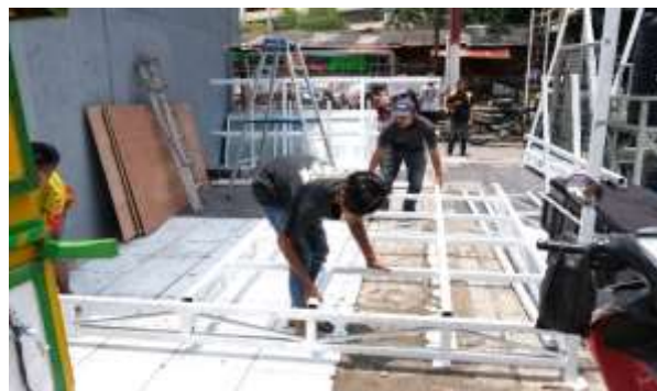
Gambar 8. Proses Pemasangan Rangka Lantai Unit Isolasi (Sumber: Dokumentasi Pribadi, 2020)
