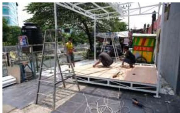
Gambar 11. Proses Pemasangan Penutup Lantai Unit Isolasi (Sumber: Dokumentasi Pribadi, 2020)
