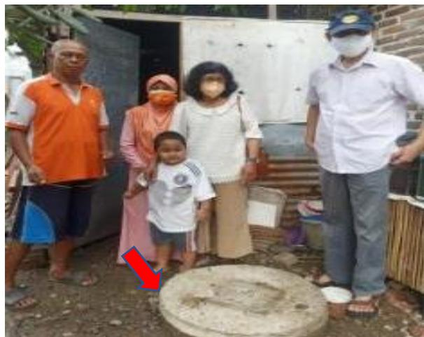
**Gambar 4.** Buis beton telah ditanam menjadi *septic tank* di rumah warga (panah merah)
