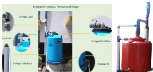
Gambar 4. Komponen instalasi pemanen air hujan
